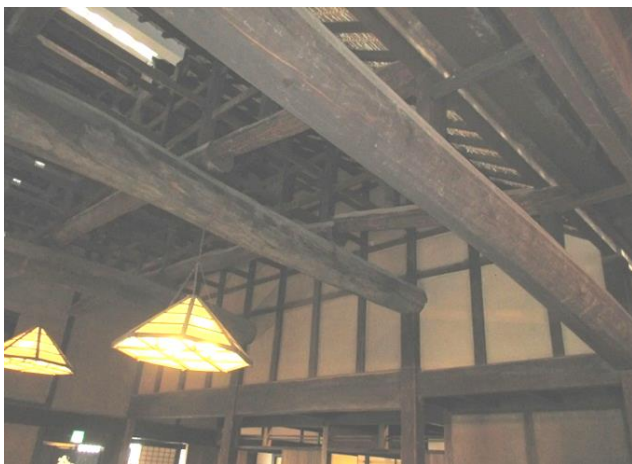
店舗の小屋組み
